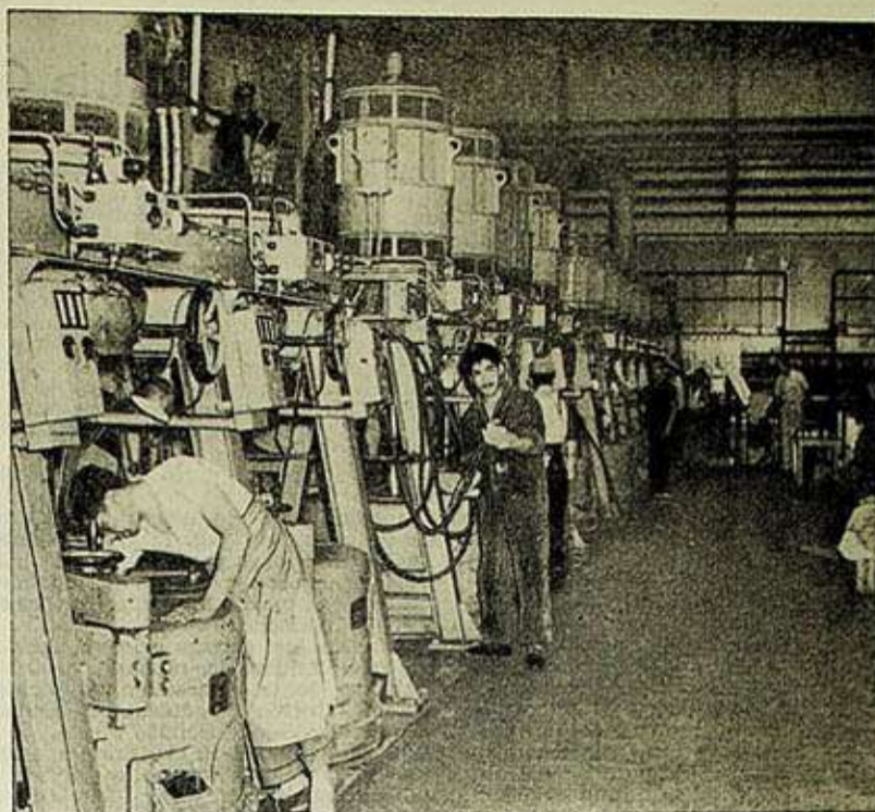
Aspecto interior de la planta de la Industria Azucarera Nacional, S. A., en Los Angeles.
