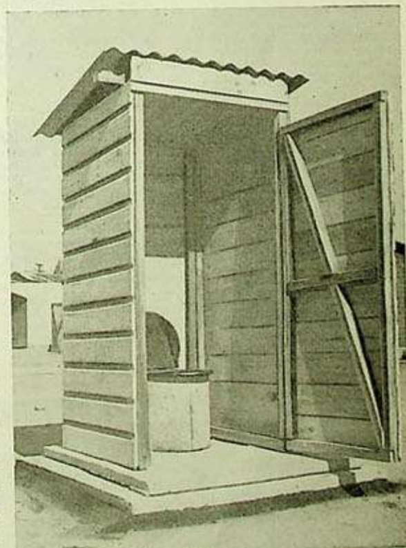
Letrina económica, del tipo que se instalará en varios predios agrícolas que en la actualidad se desenvuelven en deplorables condiciones higiénicas.
